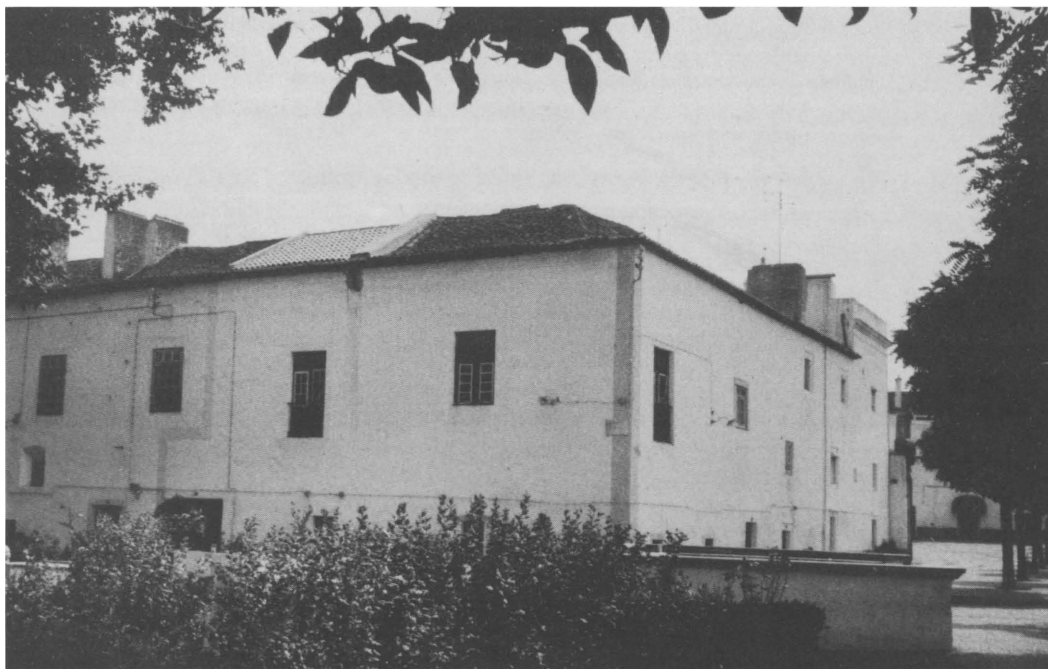
Fot. 6. A casa de Fernão de Sousa em Vila Viçosa, actualmente
